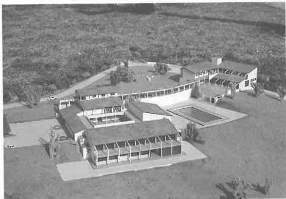
Vista general del Projecte de la Residència-Escola (La Roca).
